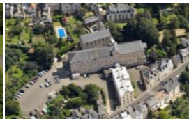
Centre de soins de suite Georges Coulon – Site du Mans
